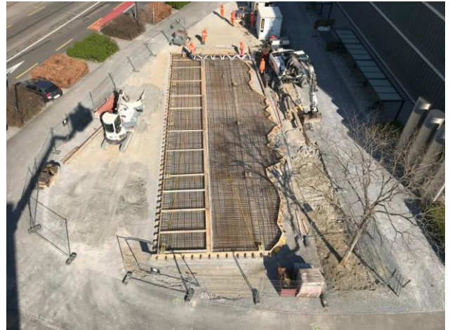
Betonieren der Bodenplatte vor dem PwC-Gebäude an der Birchstrasse
