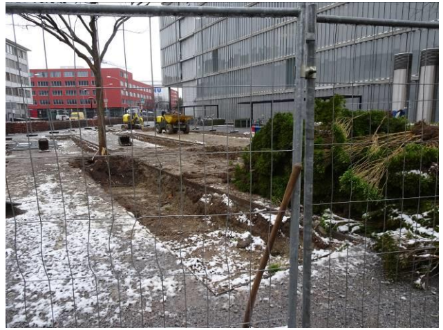
In der gleichen Woche beginnt der Aushub der Buchshecken
