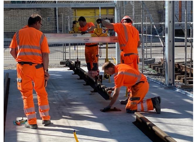
Am 27. Mai werden die 25 Meter Schienen auf der Bodenplatte fixiert
