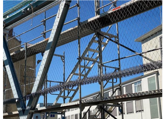
Vielfältige Arbeiten: Schiebtor, Gitter, Elektrisch, Rinnen, Rohre, Dach
