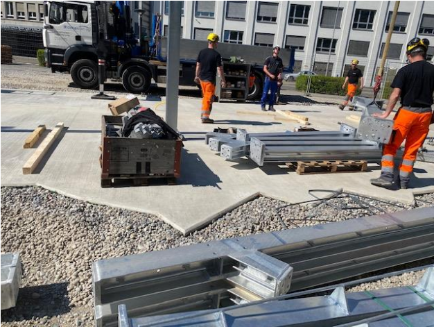
6. April: Bauteile der Y-Masten für die Dach-Konstruktion sind bereit
