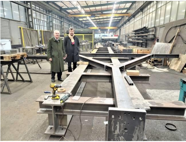
Konstruktion bei Schneider Stahlbau, Jona am 27. Februar 2020
