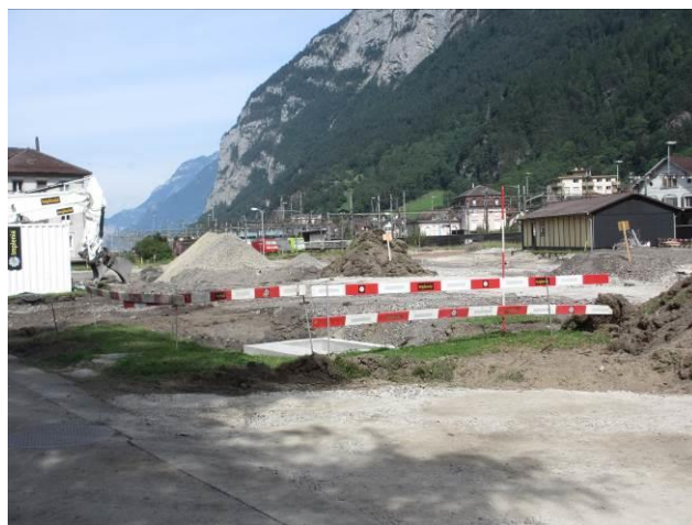
Baustelle am früheren Standort der CE 6/8, Nr. 14270
