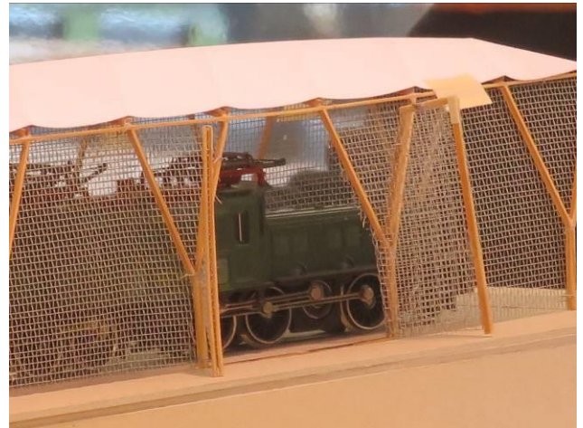
Zwischen 2 Y-Trägern werden 2 Türflügel auf Rädchen laufen
